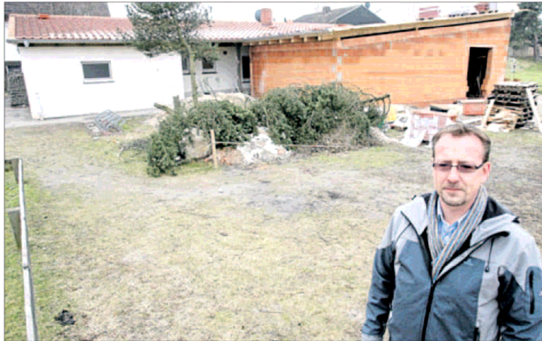
Vereinschef Klaus Jacobs zeigt die Baustelle des Meinkoter Sportvereins.
