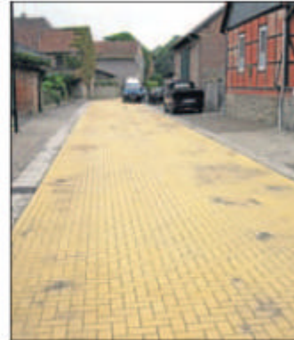
Der Meinkoter Wiesengrund ist fertig gepflastert. Die Seitenstreifen zielt das aufgearbeitete Natursteinpflaster, das sich unter der alten Asphalt-schicht fand. Morgen nimmt die Gemeinde die Arbeiten ab. Foto: Franz
