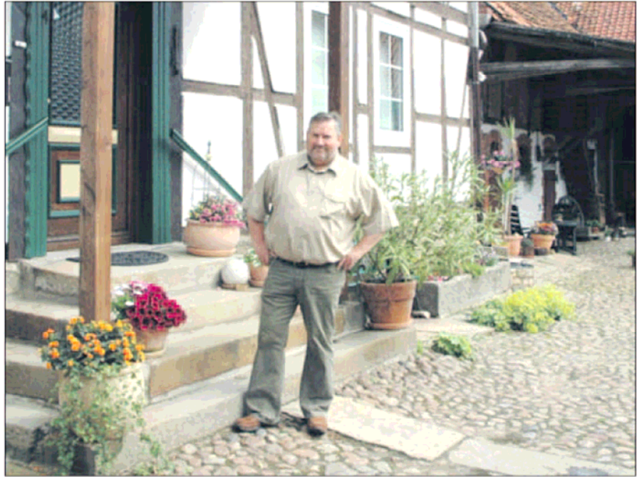
Gerhard Schulze hat in seinem Haus aus dem Jahr 1820 schon erste Risse entdeckt. Grund sei der anhaltende Schwerverlastverkehr. Foto: Schlegel
