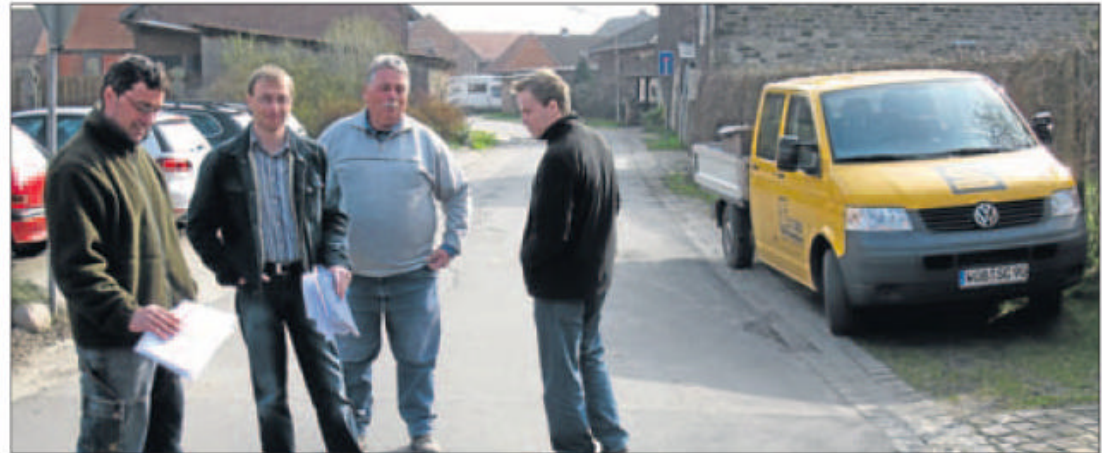
Dieter Gissel (zweiter von links) vom Ingenieurbüro Steinkopf bespricht mit den Bauarbeitern der Firma Sturk das Vorgehen im Meinkoter Wiesengrund. Foto: Christian Franz
