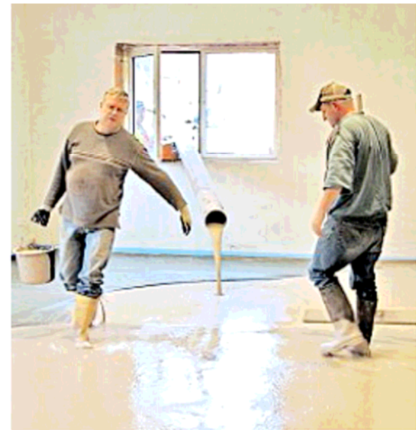
Meinkot: Die Sportler verteilten den Estrich im neuen Sportheim-Anbau. Fotos: Imke Schulze
