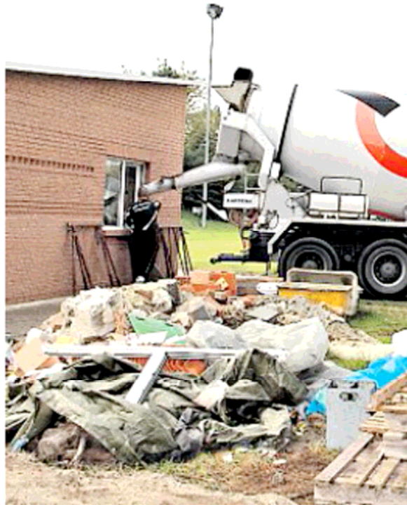
Anbau am MSV-Vereinsheim: Die Arbeiten verzögern sich etwas – Ende des Jahres soll alles fertig sein.
